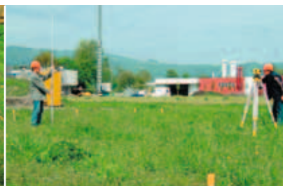
Nivelación de superficies
